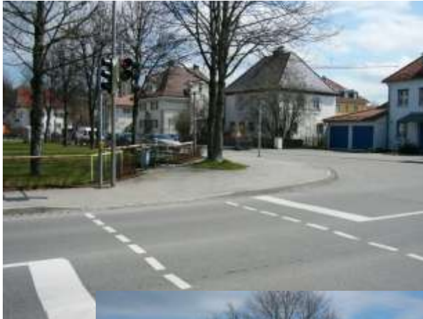
Bestand vor Baubeginn:
