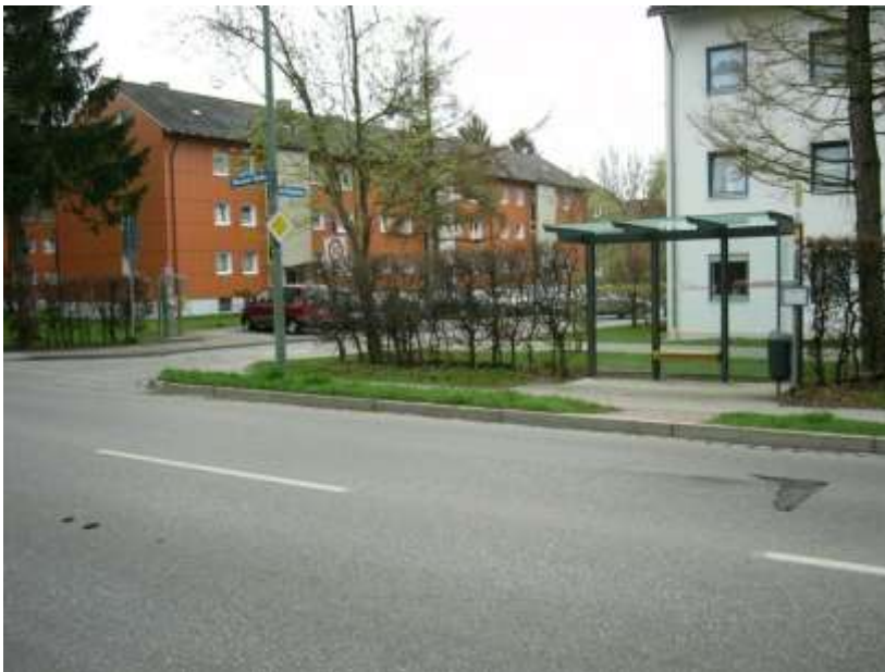
Bestand vor Baubeginn:
