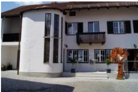
HdB Außenansicht, rechts neben der Türe befindet sich die Rampe für den barrierefreien Zugang
