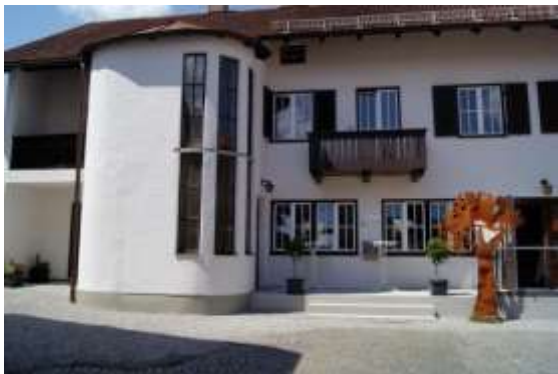
HdB Außenansicht, rechts neben der Türe befindet sich die Rampe für den barrierefreien Zugang
